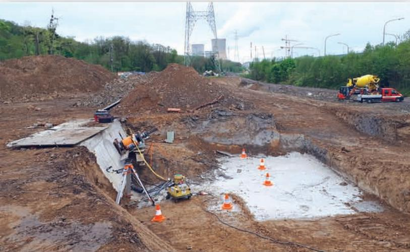
> L'agence Rincenc Nord-Pas-de-Calais réalise régulièrement des essais en Belgique, cela a été le cas sur le chantier de réhabilitation et d'extension de l'Ecluse d'Ampsin-Neuville à Ampsin. Il s'agissait de réaliser un essai à la rupture sur un tirant ne faisant pas partie de l'ouvrage mais ayant les mêmes caractéristiques.
